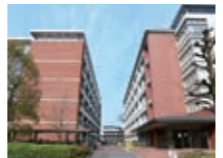
G棟・先端科学研究棟
