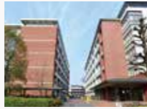
G棟・先端科学研究棟
