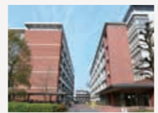
G棟・先端科学研究棟
